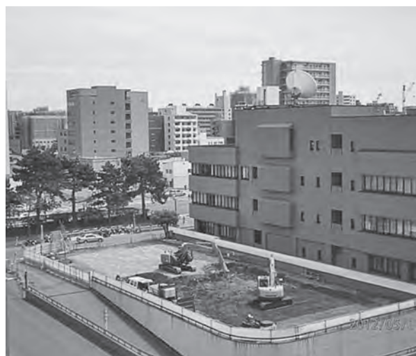
雨の中、重機が入り建築予定地の整備が始まりました
