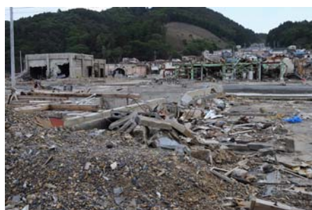
がれきが散乱している女川町内
